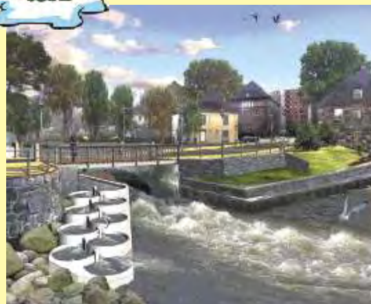
Der mittlere Brückenteil mit der zukünftigen Fischtreppe.
