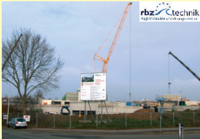
Seit diesem Sommer wird gebaut, schon im Oktober 2012 soll alles bezugsfertig sein.
