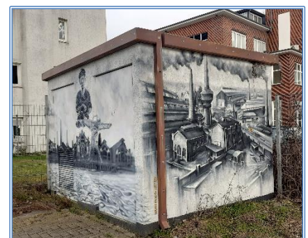
Neu gestaltetes Stromhäuschen unter der Gaardener Brücke: Maßnahme zur Umfeldaufbesserung 2020
