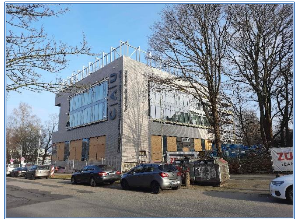
Öffnung der Technischen Fakultät zum Stadtteil: Hörsaalgebäude Ecke Elisabethstraße/ Norddeutsche Straße im Februar 2023
