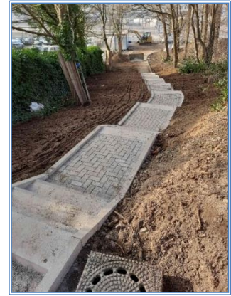
Im Bau befindliche neue Treppenanlage von der Kieler Straße zur Werftstraße (Februar 2023)
