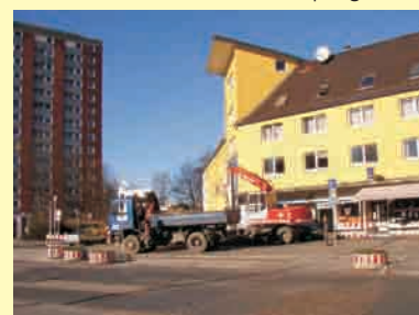
Bauarbeiten im Wellingdorfer Zentrum: Der erste Bauabschnitt ist beinahe fertig.
