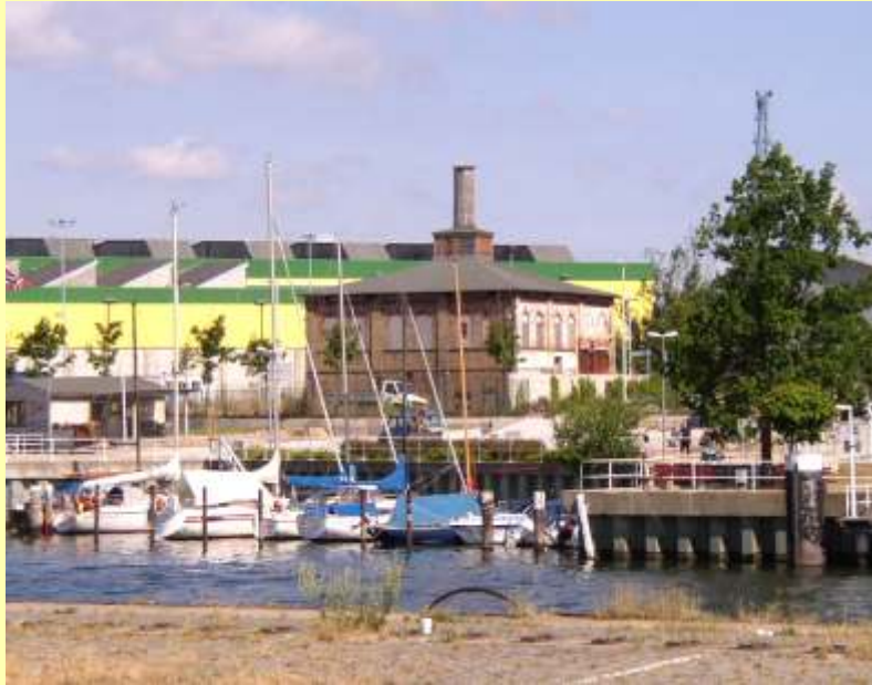
Die Alte Metallgießerei am Schwentineufer, noch in schlechtem Zustand, bald schon ein Industriemuseum.
