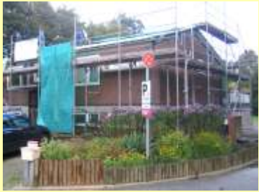
Die letzten Arbeiten am Vereinsheim werden voraussichtlich im Januar abgeschlossen.
