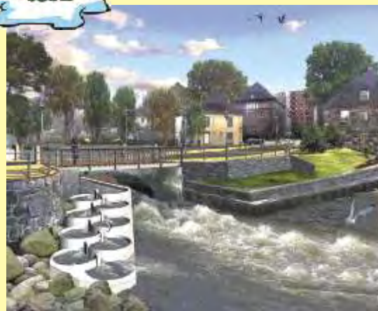
Der mittlere Brückenteil mit der zukünftigen Fischtreppe.
