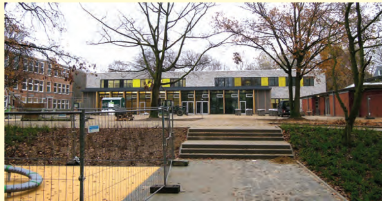
Im Neubau der Hans-Christian-Andersen Schule befindet sich unter anderem die Mensa.
